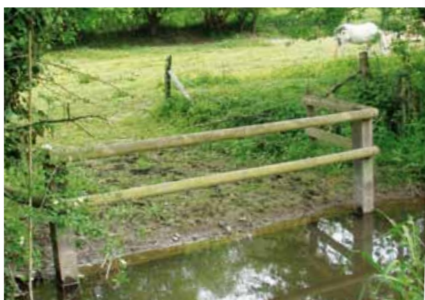
Une simple descente en bois, permet aux bovins de boire sans pénétrer dans le cours d'eau.
